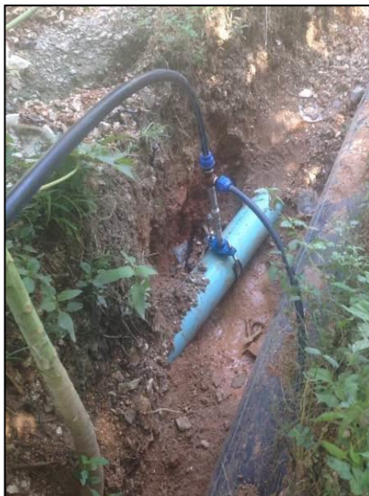
Foto 5 & 6.- Obras del proyecto de rehabilitación y extensión del sistema de agua potable de la ciudad de Miragoane (Detalle ejecución zanjas y pruebas de presión)
